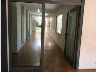
Tür auf dem Weg vom Aufzug zu den Zimmern Nr. 08 und 33 (1. Stock)
