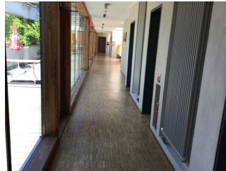
Weg zwischen Tür zum Flur und Zimmer Nr. 33 (1. Stock)
