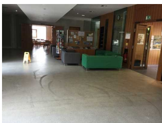
Weg zwischen Rezeption und Tür zur Terrasse
