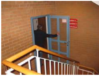
Flur und Treppenhaus
