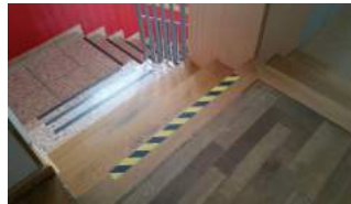
Treppe von oben
