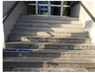
Treppe zum Nebeneingang
