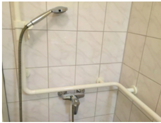
Haltegriffe und Duscharmatur
