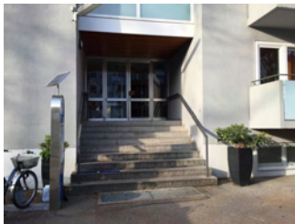
Treppe zum Nebeneingang
