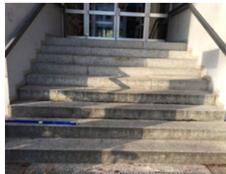
Treppe zum Nebeneingang
