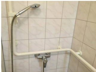
Haltegriffe und Duscharmatur
