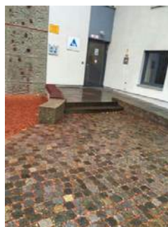
Treppe und Rampe Nebeneingang
