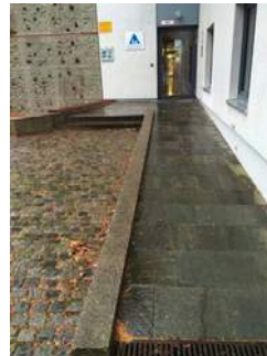
Rampe und Treppe Nebeneingang
