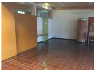
Tagungsraum(5 gleiche Tagungsräume)
