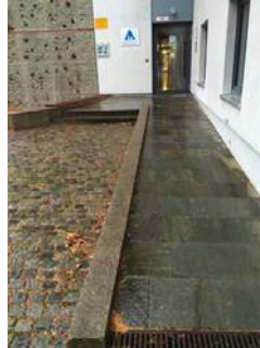
Rampe und Treppe Nebeneingang
