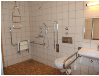
Sanitärraum im Zimmer 127
