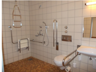
Über Duschsitz befindet sich zusätzlich ein Galgen zum Hochziehen
