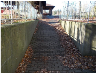
Sicht auf Rampen, die durch Podest unterbrochen ist.
