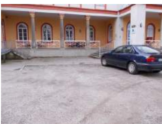
Weg von Parkplatz zu Rampe
