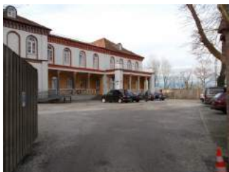
Einfahrt mit Parkplätzen
