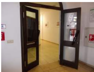
Durchgangstür zu Tagungsraum bzw. Sanitärraum
