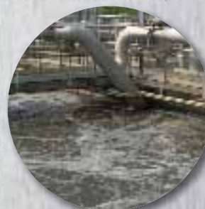
Tratamiento de aguas residuales
