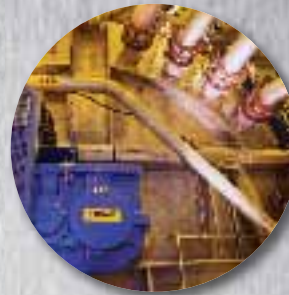
Equipos de calefacción
