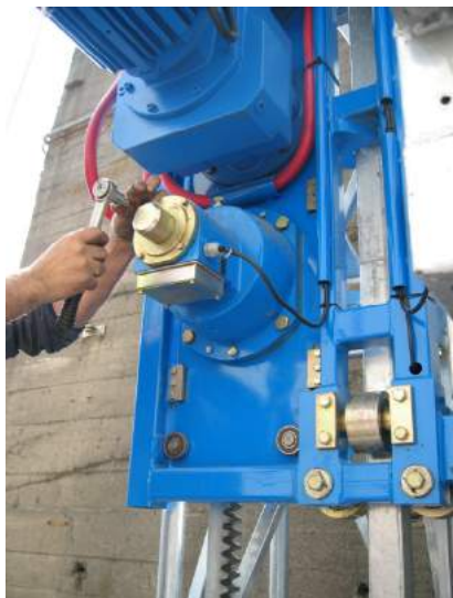
Fig. 12-17 Soltar la tapa y medir la distancia entre Tuerca y Husillo
