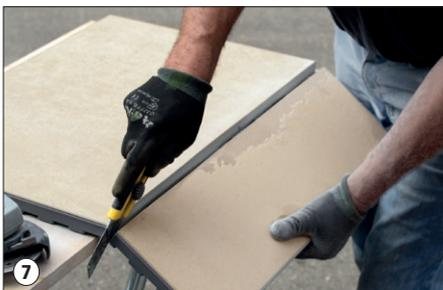
7 Schneiden des PUR-Kunststoffes mittels Stichsäge mit Laminatsägeblatt.
