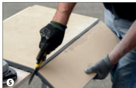
5 Schneiden des PUR-Kunststoffes mittels Stichsäge mit Laminatsägeblatt.
