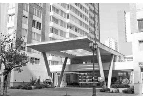
Edificio Alto Plaza Bulnes
