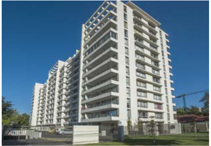
Edificio / Ossa Mayor
